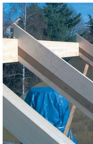
Passivhaus-Dachsystem: Dämmsparren der Firma Kaufmann
