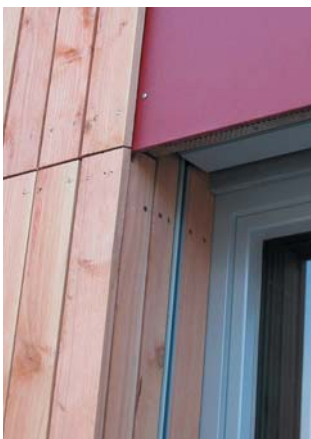
Der Jalousiekasten verschwindet hinter der Fassadenbekleidung des Hauses
