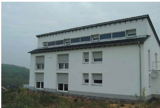
Links: Screens im WDVS eines gemauerten Passivhauses; daneben: ein in die Putzfassade eingebauter Rollladenkasten
