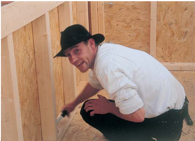
Innere Schale der Außenwand: Holzrahmenbau mit außenliegender luftdichter Beplankung aus OSB-Platten (oben links)
