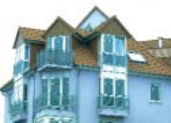
Energetisch ungünstig: große Gebäudeoberfläche
